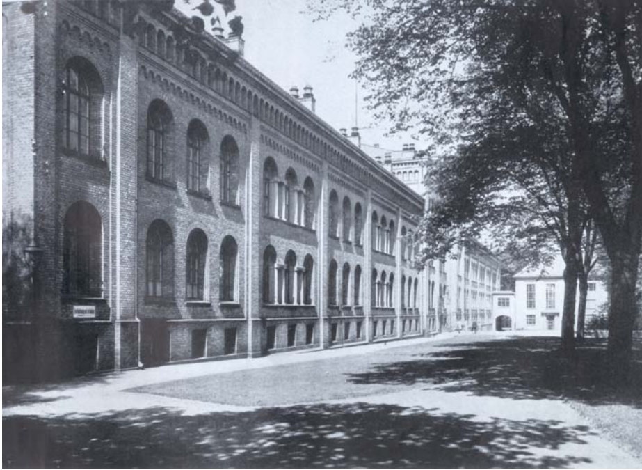
Abb. 5: Hauptgebäude der neuen Medizinischen Klinik (1928) in der Feldstraße, später Tirpitzstraße, heute Schittenhelmstraße. Rechts im Hintergrund das neue Hörsaalgebäude.
